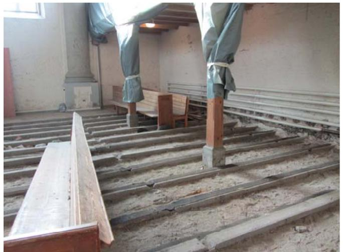
Blick unter die Westempore. Deutlich zu erkennen sind die Betonfundamente, die unter den Podesten sich befanden.
