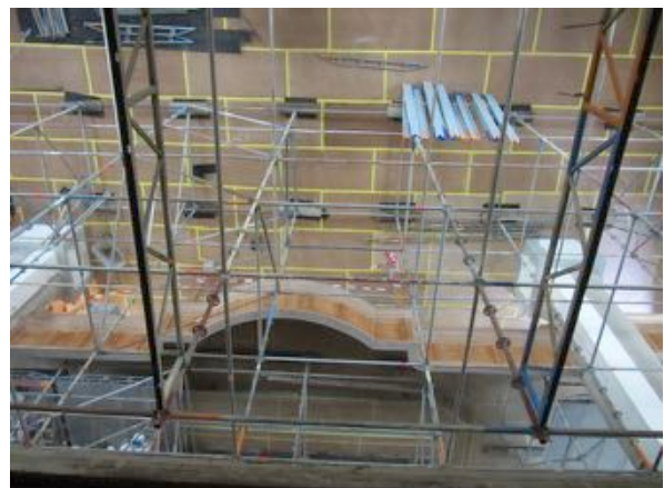
Nachdem der Fußboden verlegt war, wurde ein Innengerüst in der Kirche aufgestellt, um die Decke zu restaurieren. Dieses Bild ist vom Dachboden aufgenommen, zu erkennen ist die Empore vor der Orgel.
