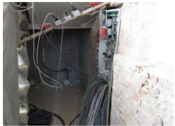
Viele hundert Metern Kabel sind in der Kirche verlegt worden. Sie ist damit auf dem neuesten Stand der Technik.
