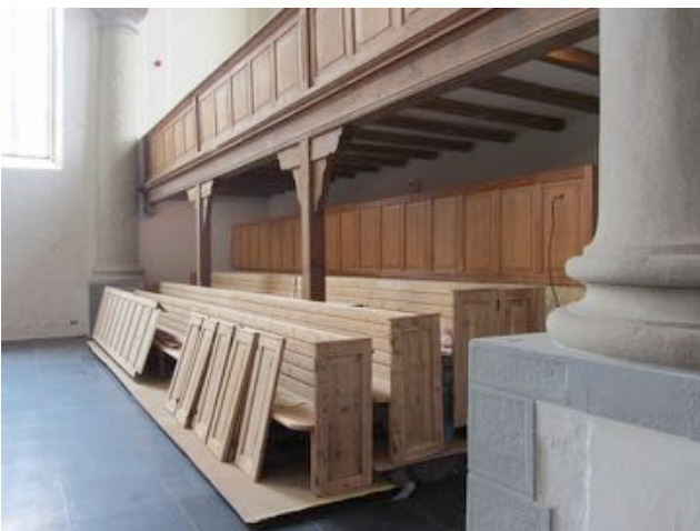
Unter den Emporen im Westen und Osten sind Podeste eingebaut worden, auf denen Bänke aus dem alten Holz installiert wurden.
