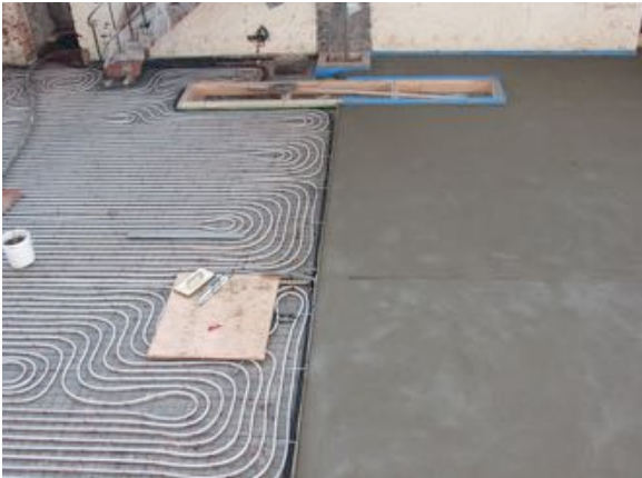
Nachdem die Schlaufen für die Fußbodenheizung verlegt wurden, ist der Boden mit Estrich aufgefüllt worden.
