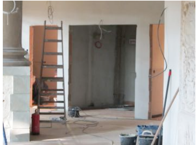
Die Zwickelbauten sind komplett verändert worden: Die Außentüren schlagen nun nach außen auf, die Innentüren sind versetzt worden. Hier sind moderne Toiletten und eine Küche eingebaut worden.
