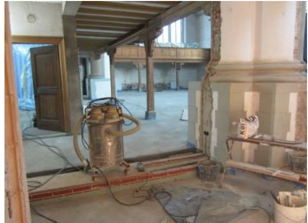
Blick aus dem Vorraum in Richtung Konsistorienkammer und Innenraum.
