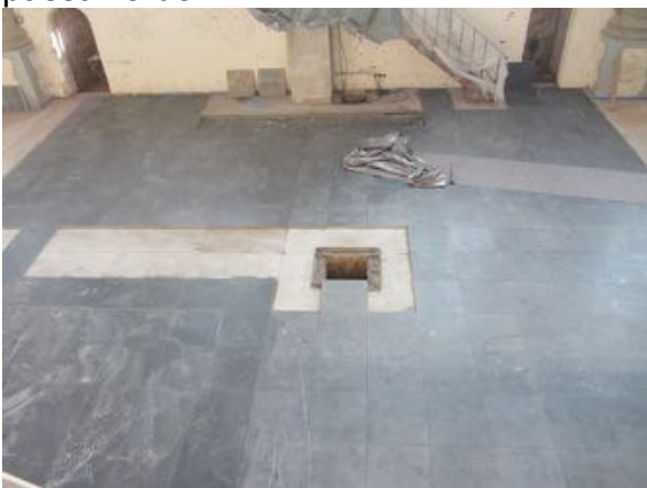
Nach dem Trocknen des Estrichs konnte der Aachener Blaustein als neuer Fußboden verlegt werden. In der Mitte ist der Schacht für die Kabel zu erkennen.
