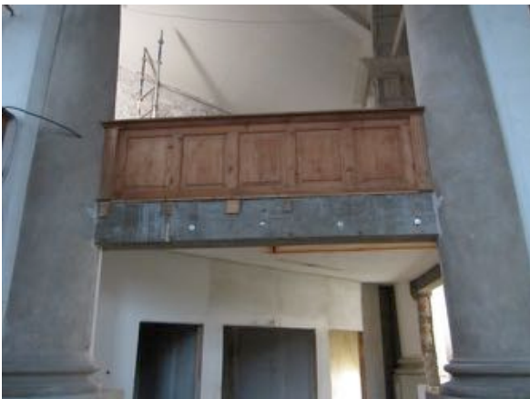
Unter der Empore sind neue Unterzüge montiert worden und die Säulen mussten entsprechend von einem Restaurator angepasst werden.
