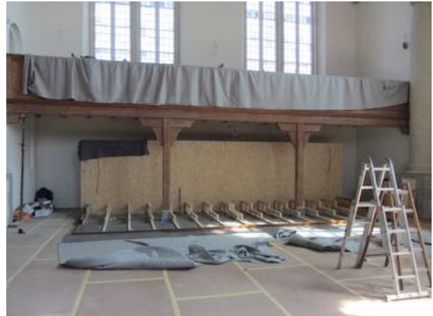
Unter den Seitenemporen ist ein Podest montiert worden, auf dem drei Bankreihen aus dem Bestand der alten Bänke gebaut wurden.
