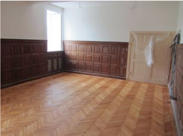
Die Konsistorienkammer hat eine zweite große Tür erhalten. Der Fußboden ist abgeschliffen worden, die Vertäfelung restauriert.
