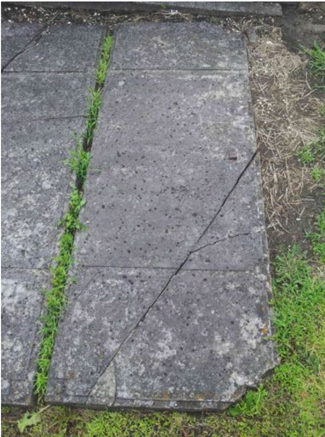
Gerade ältere Grabplatten weisen einen hohen Grad an Bruch- und Witterungsschäden auf.
